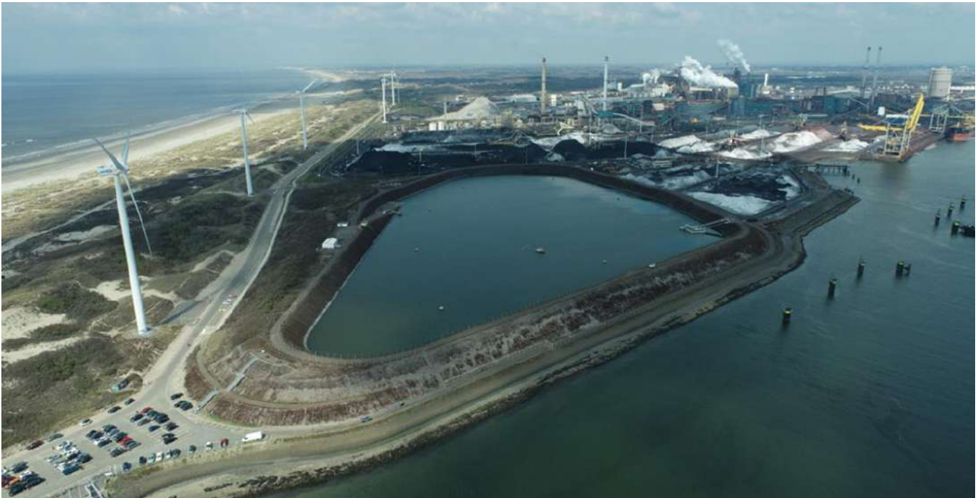
Figura 5-3 Baggerdepot the Slufter cerca de Róterdam, Países Bajos: https://www.portofrotterdam.com/nl/bouwen-aan-de-haven/lopende-projecten/de-slufter
