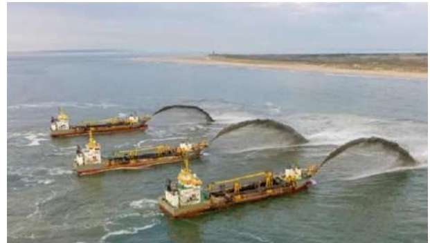
Figura 3-3: Métodos típicos de esparcimiento de sedimentos marinos en zonas marítimas y costeras. Fuente: Departamento holandés de Vías Navegables y Obras Públicas
